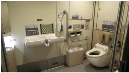
多目的トイレ
